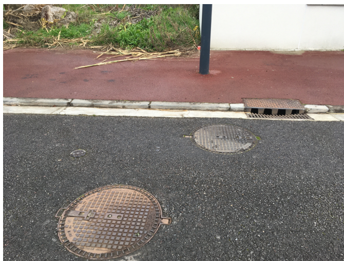
Photographie n°7 : vue réseaux eaux devant accès
