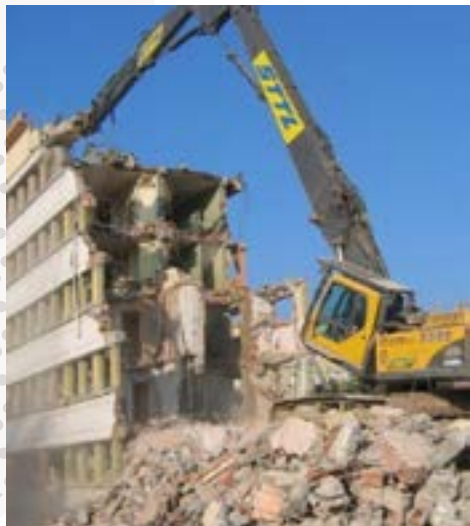
Démolition d'un bâtiment R+4
