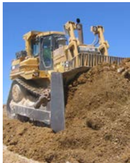
Terrassement du terrain
