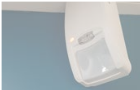
Système de détection de présence dans les circulations
