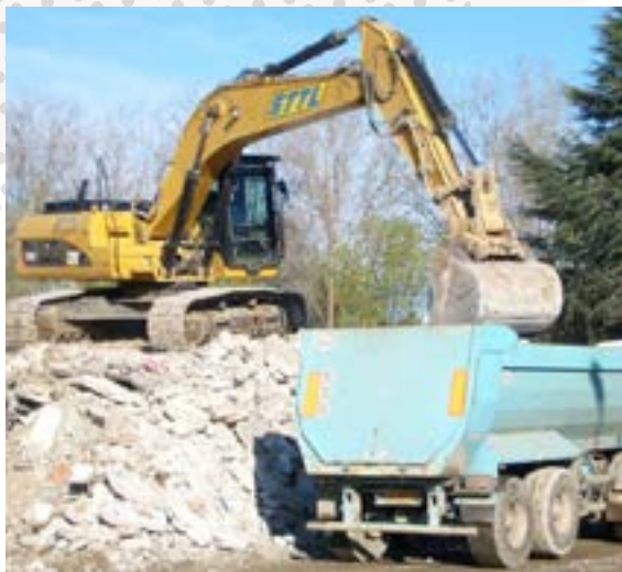
Chargement de gravats
