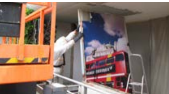
Dépose en un seul élément des panneaux amiantés
