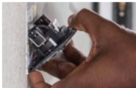
Réfection complète des installations dans les logements
