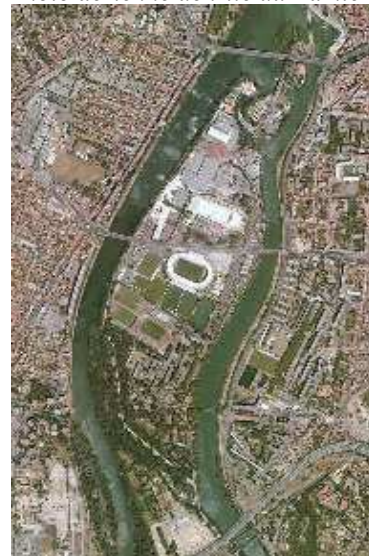
Photo aérienne de l'île du Ramier
