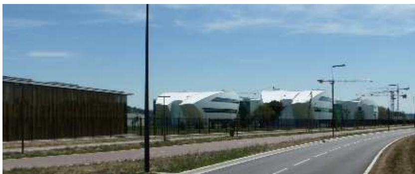
Cancérôpole en construction
