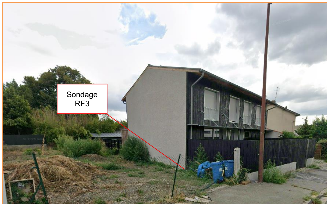
Vue de la maison d'habitation 16 rue Cambigue et localisation du sondage RF3
