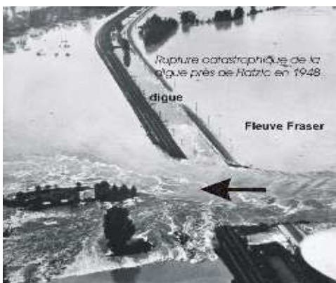
Rupture de digue au Canada sur le Fraser en 1948, source site internet canadien
